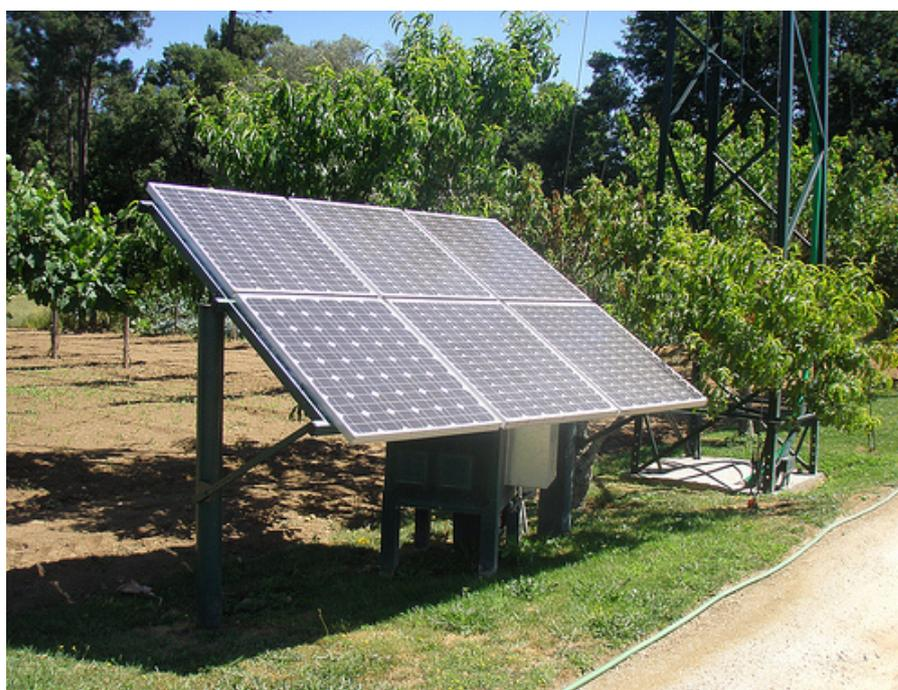
**Figura 22.** Um painel fotovoltaico numa exploração agrícola. A preferência vai para os painéis fixos em detrimento dos que possuem seguidores: menor investimento, pouca manutenção e, geralmente, maior eficiência sob condições atmosféricas adversas.
